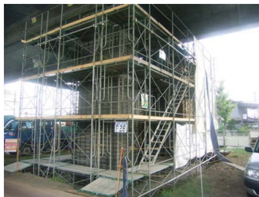
《施工状況》 道央道 白石高架橋
